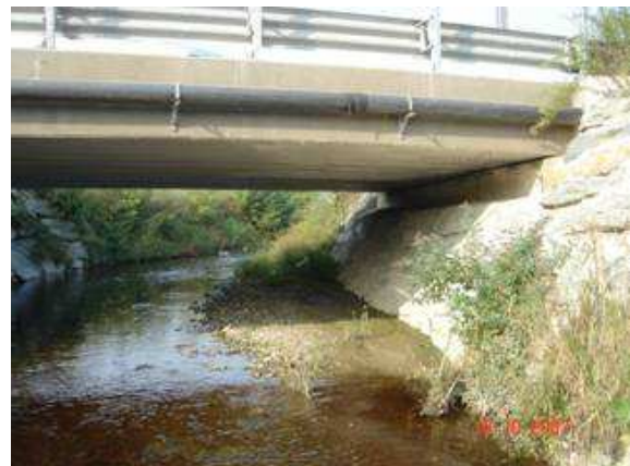
Brücken sind nur dann geeignet, wenn der Otter trockenen Fusses unten durch gehen kann und so auch eine Stelle zum Markieren findet. Diese Brücke in Norditalien wäre geeignet. Leider gab es hier keine Otterspuren.
